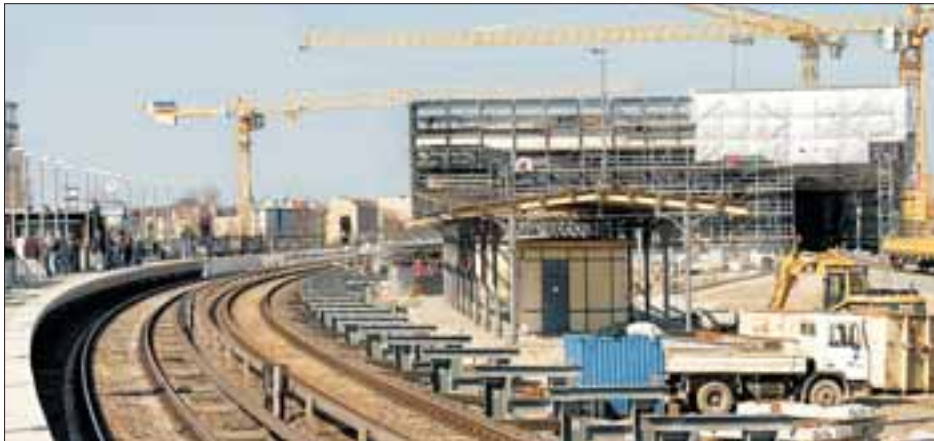
Noch gehen die S-Bahngleise links an der im Bau befindlichen Ringbahnhalle am S-Bahnhof Papestraße vorbei. Bereits ab 4. April führt das rechte Gleis in die Halle hinein und die Züge halten bereits am neuen Bahnsteig. ▶ Foto: David Ulrich
