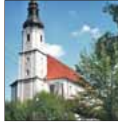
Foto: Ev. Pfarramt Cunewalde
