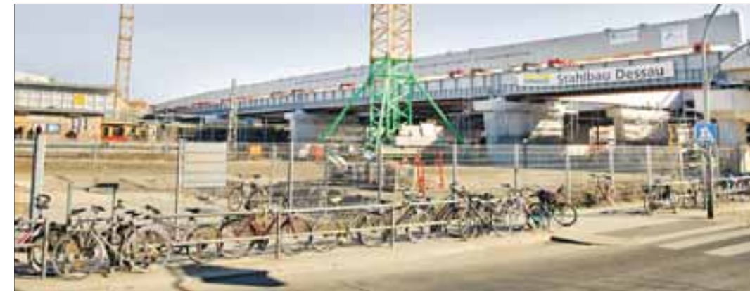
Zwei dieser 146 Meter langen Stahlträger bilden das Fundament für die künftige Ringbahnhalle.
