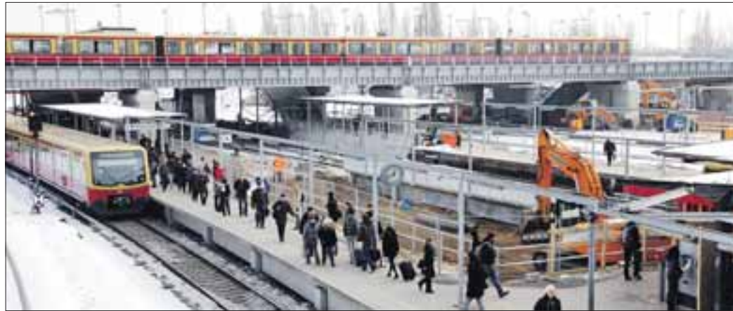
Wo es der Frost zulässt, gehen die Arbeiten weiter. Auf den Bahnsteigen D und E sind die Dächer abgebaut. FOTO: DAVID ULRICH
