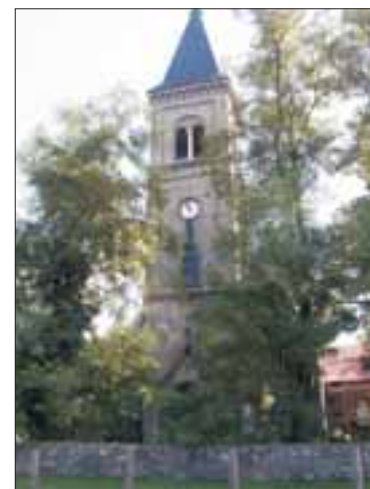
Kirchenmobiliare, Farbanstrich, Heizungseinbau... Für Spenden ist man deshalb dankbar. ● mpj
